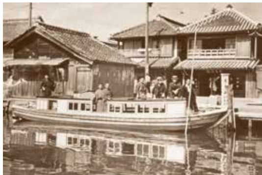
水上交通が盛んだったころの小見川渡船場
