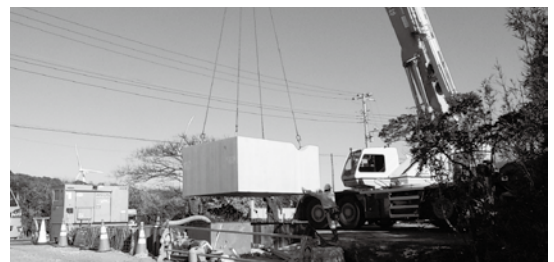
雨水排水対策工事
