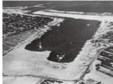
鹿島港中央航路の掘削 (1967年)
